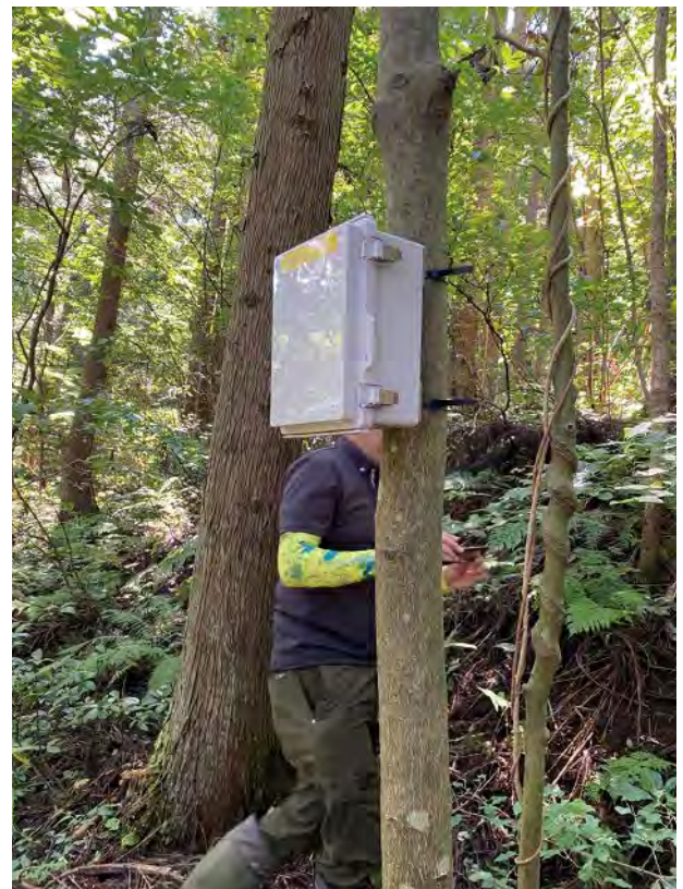
図-8 メールを発信するための通信装置（子機の近くにセット）
